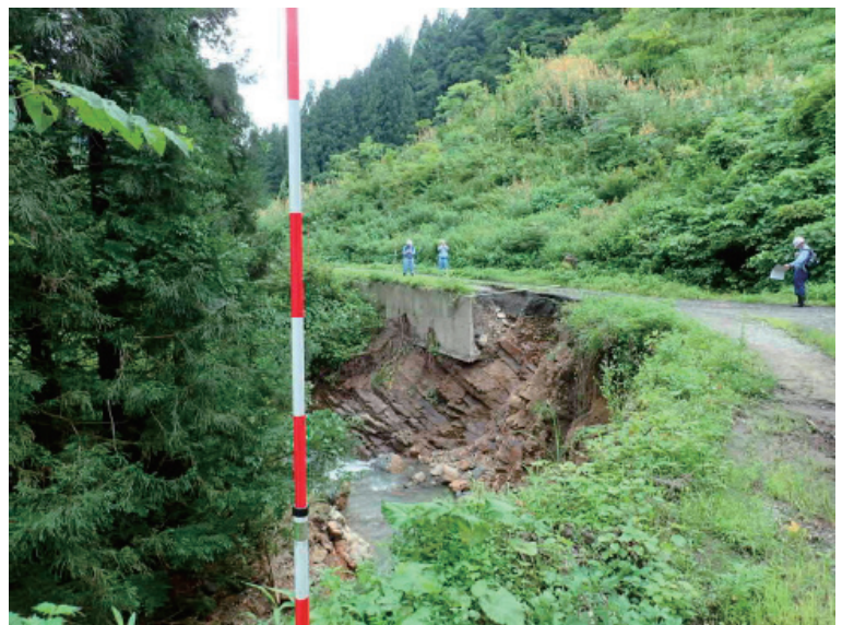
町道 高旭東浦線 (TEC-FORCE 調査状況)
