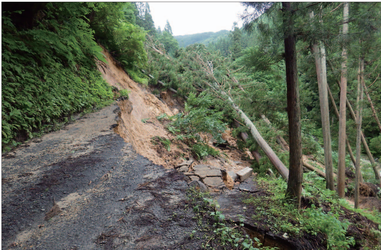
令和2年7月豪雨による被災状況（山形県西川町）
