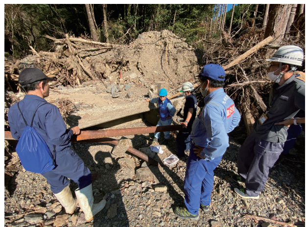
町道 牧原線牧良高橋箇所
