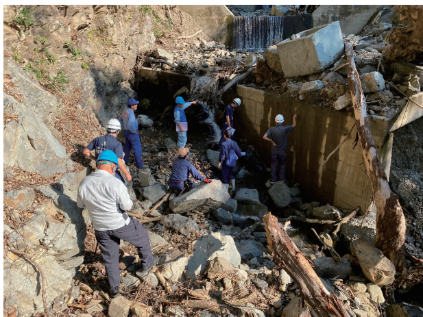
町道牧原線上牧良橋箇所
