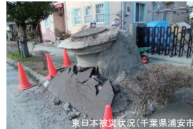
東日本被災状況(千葉県浦安市)
