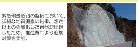
緊急輸送道路の整備において、詳細な地質調査の結果、想定以上の強風化した岩盤が出現したため、推進費により追加対策を実施。
