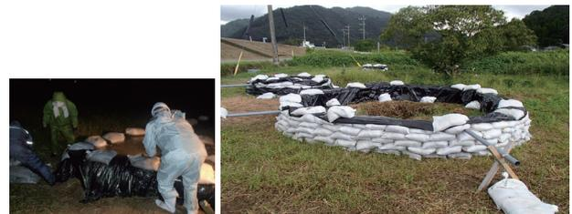
写真 1 漏水における応急対策工
