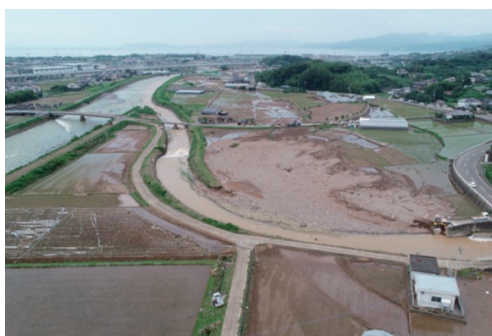
写真－1 河川護岸決壊状況
