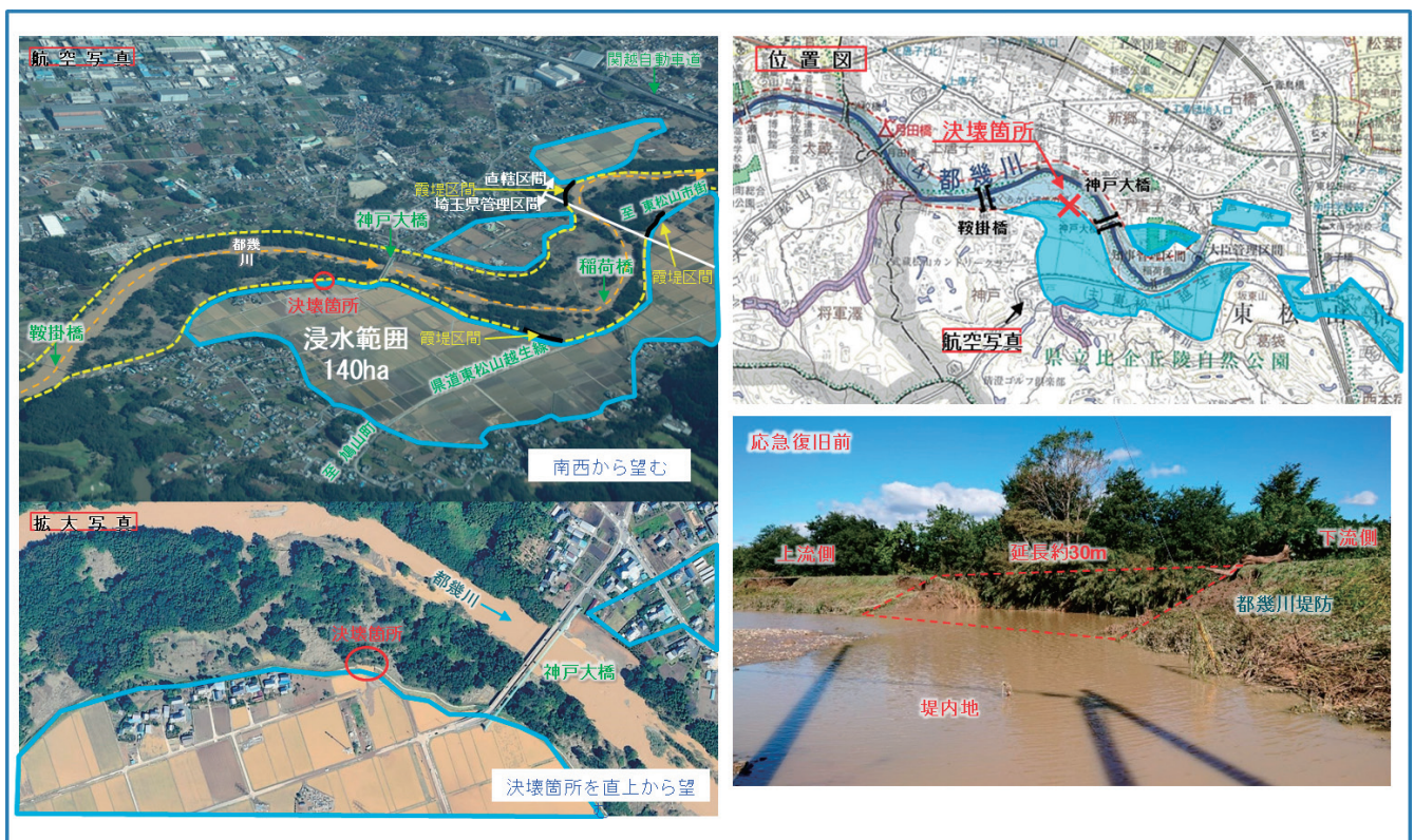
図-3 一級河川都幾川の決壊状況
