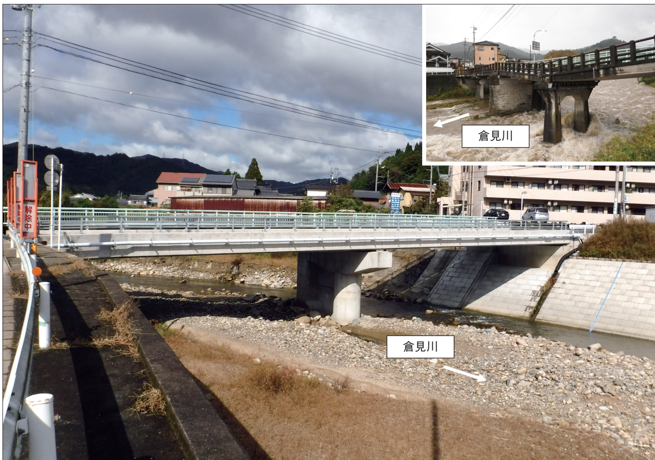
平成29年台風21号による豪雨により被災した岸本橋の橋梁災害関連事業が令和2年6月に完了しました。被災原因となった橋脚数を3基から1基として河積阻害率を下げ、道路幅員を前後道路に合わせて拡幅しボトルネックの解消を図りました。 (写真提供：岡山県、平成29年発生災害採択事例集掲載事業)
