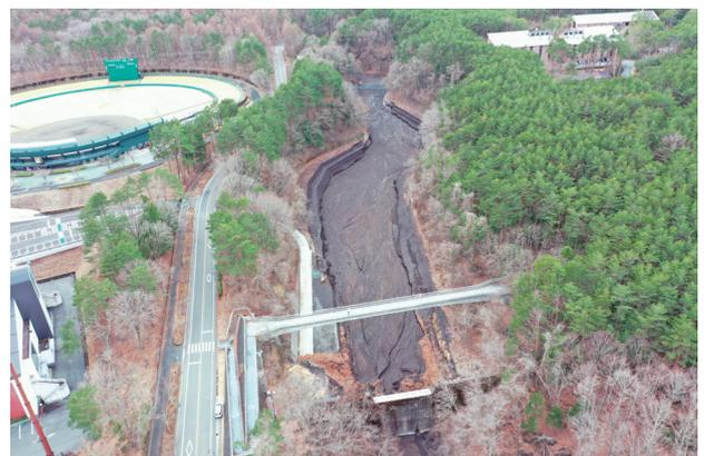
写真-12 宮川堰堤工の土砂捕捉
