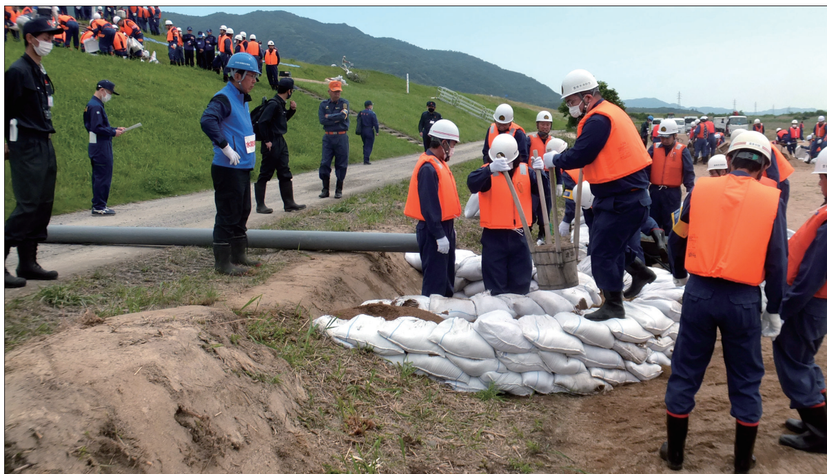
R5.6.4 令和5年度 斐伊川水防訓練 (公社)全国防災協会から水防専門家を7名派遣 (工法指導)
