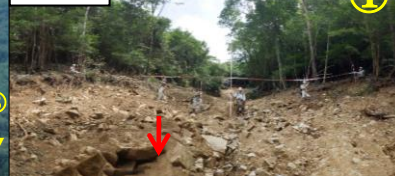
浸没状況 (発生区間)
