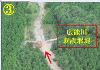
堰堤上流状況
