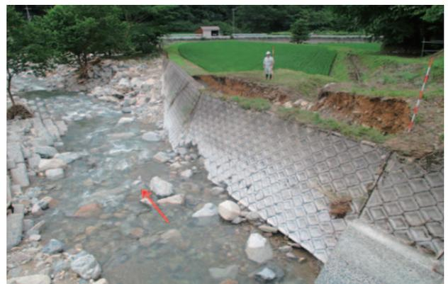
河床洗堀による護岸、根固め被災
