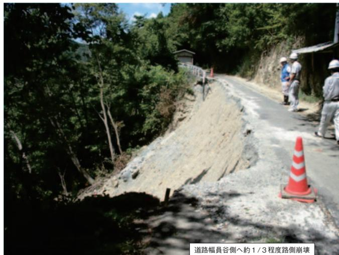
道路幅員谷側へ約 1/3 程度路側崩壊
