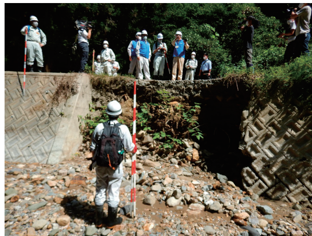
町道高旭東浦線 普通河川海味川
