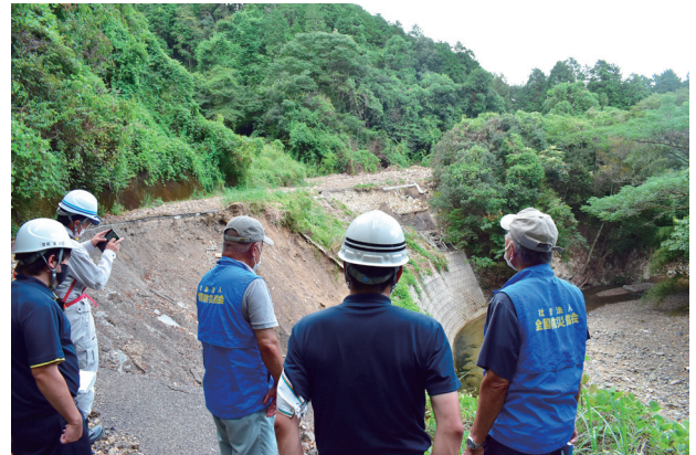
路面崩壊状況
