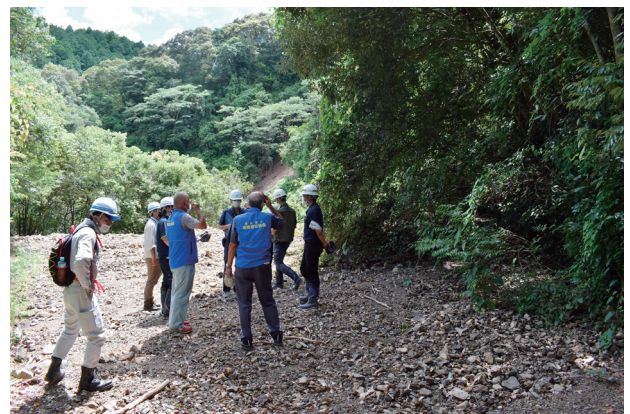
山側土砂流出状況
