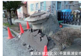
東日本被災状況(千葉県浦安市)
