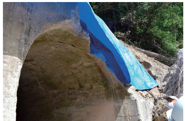
トンネル坑口崩壊及びトンネル欠落状況
