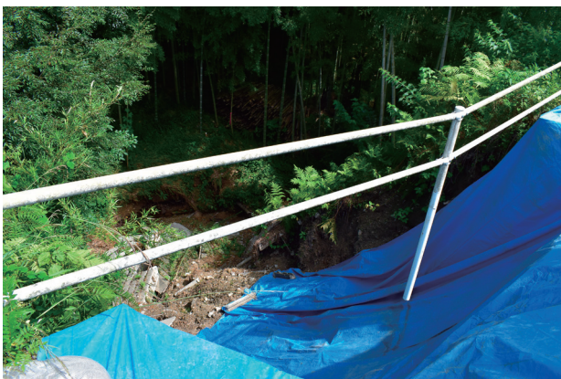
護岸崩壊状況
