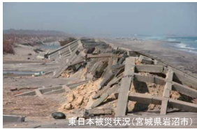
東日本被災状況(宮城県岩沼市)
