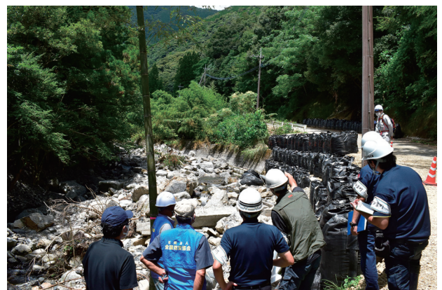
応急仮工事实施状況
