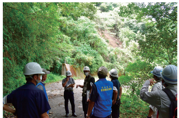
山側法面崩壊状況
