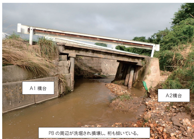
二級河川広長川に架かる市道前林線前田橋が被災
