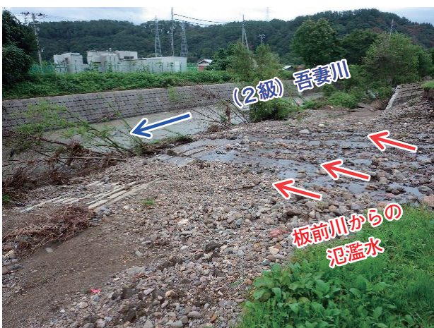
板前川からの氾濫水による護岸倒壊状況
