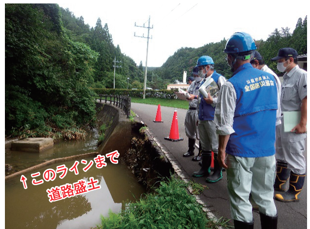
中沢川⑧ 被災及び現地説明状況
