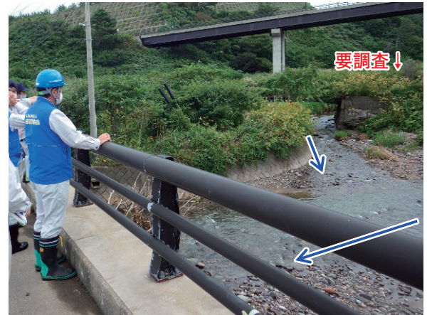
母沢川⑤-1 被災状況及び助言状況
