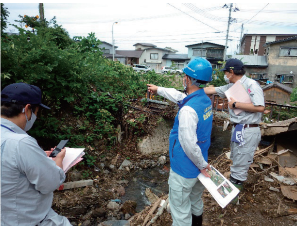
隣接箇所被災状況
