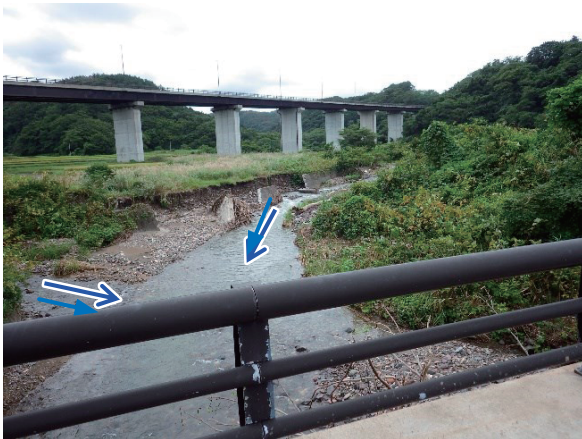
母沢川⑤-1 被災状況
