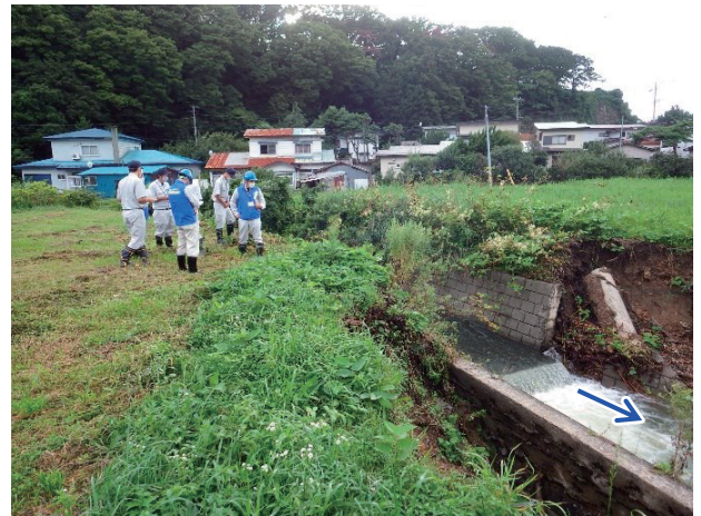
広戸川被災状況
