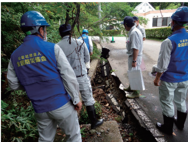
中沢川⑦ 被災及び現地説明状況
