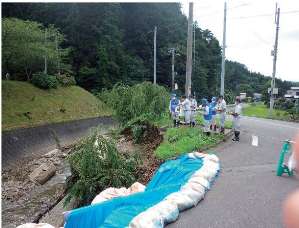
中沢川⑥ 被災及び現地説明状況
