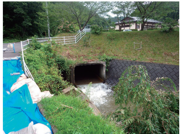
中沢川⑥ 被災状況（上流 BOX の状況）
