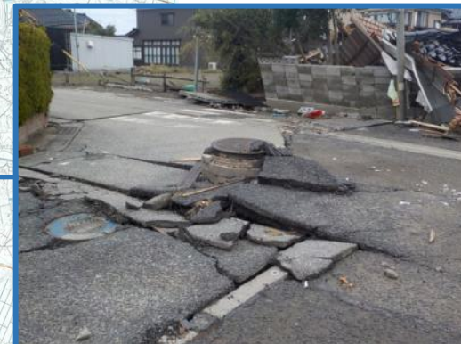
液状化・マンホール浮上
