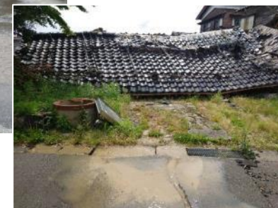
道路漏水（配水管の損傷）
