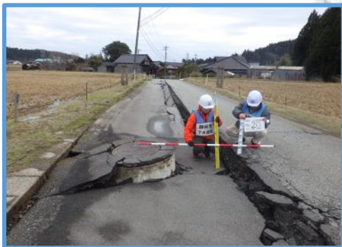
液状化・マンホール浮上・陥没
