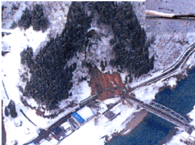
地すべり 国道156号 (富山県南砺市西赤尾町)
