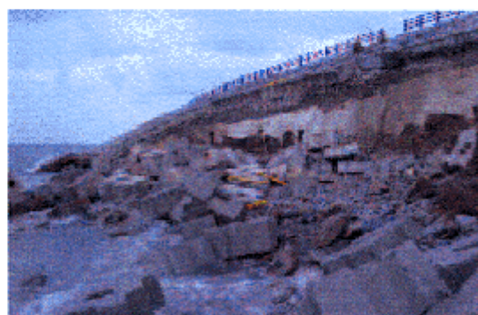
国道 449 号護岸（沖縄県名護市安和）
