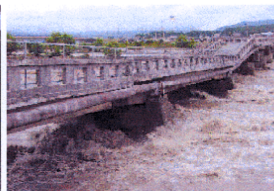
殿島橋（長野県伊那市春近）
