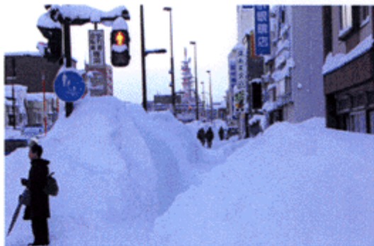
積雪状況 国道 4 号（青森県青森市栄町）
