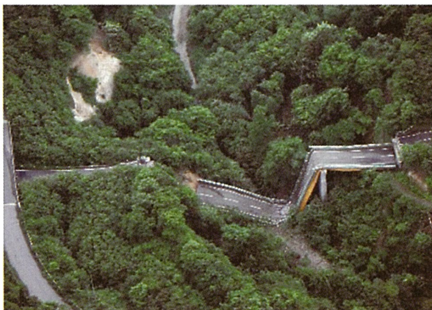
一般国道 342 号線 祭時大橋 (岩手県一関市)
