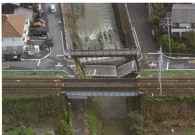
市道菰川竜泉寺川堤 2 号線 三河橋（愛知県岡崎市菰川新町地内）
