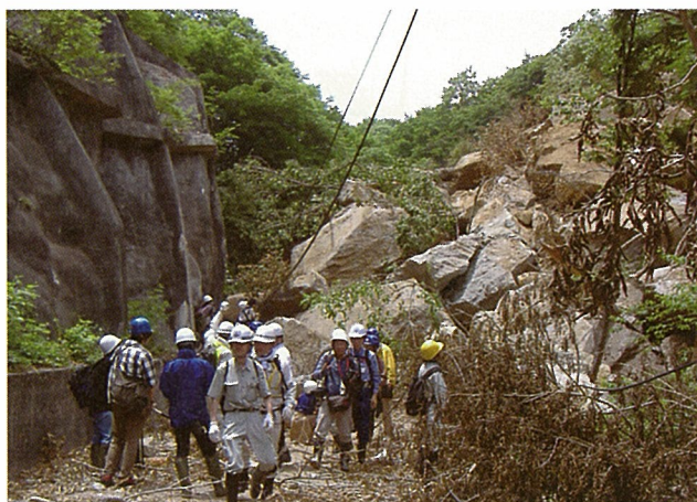
主要地方道築館栗駒公園線 (宮城県栗原市)
