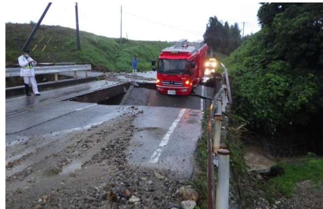
崩壊した橋りょう
