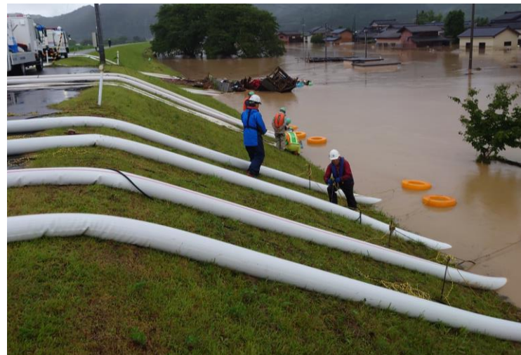
排水ポンプ車による排水作業
