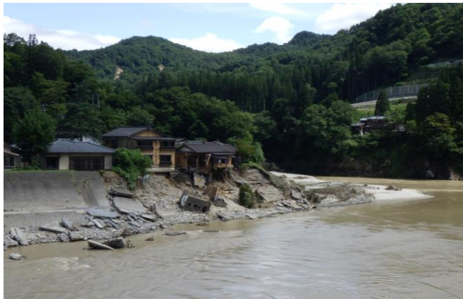
崩壊した荒川護岸 (鷹の巣温泉旅館)
