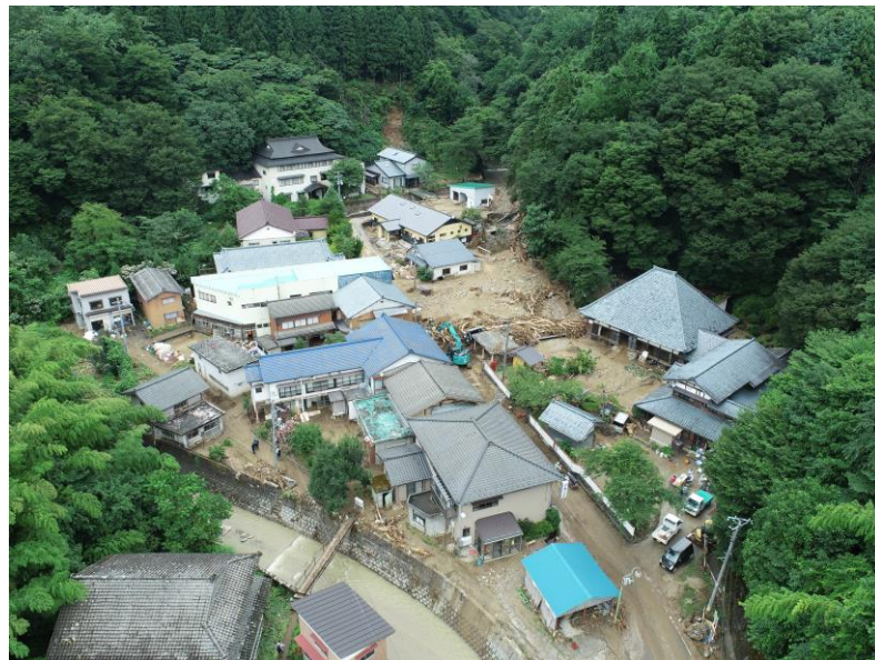
土砂に覆われた湯沢集落
