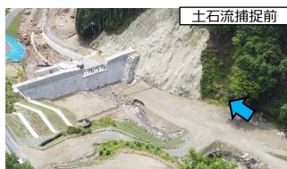
おとし 乙石川上流1号砂防堰堤
