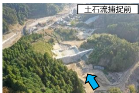
くえんたに 崩谷川砂防堰堤
