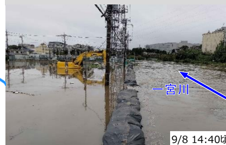
いちのみやがわ いちのみやがわ 一宮川水系一宮川の浸水状況（千葉県茂原市）
