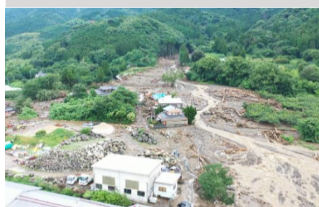
くるめし たぬしまるまち 土石流による被害（福岡県久留米市主丸町）
