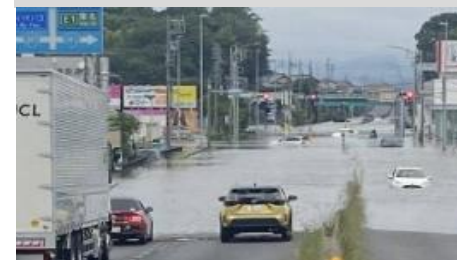
とよかわし 国道1号の冠水状況（愛知県豊川市）
