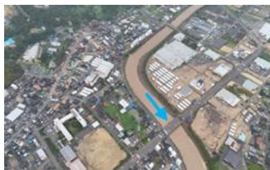
かわらだがわ 河原田川水系河原田川の浸水状況 わじまし (石川県輪島市)
