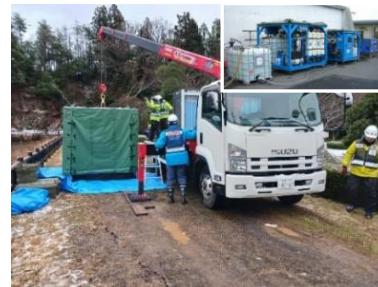
可搬式浄水施設の設置 (石川県珠州市)
