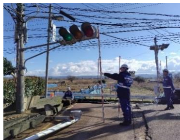
道路の被災状況調査 (石川県内灘町)
