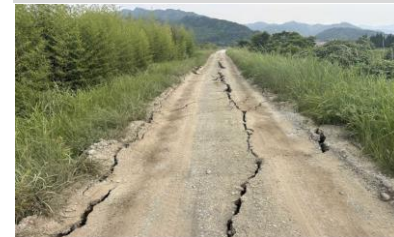
ひろとがわ ひろとがわ にちなんし 広渡川水系広渡川の堤防天端の亀裂 (宮崎県日南市)
