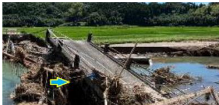
網掛川における橋梁流出・護岸損傷 (鹿児島県始良市)
