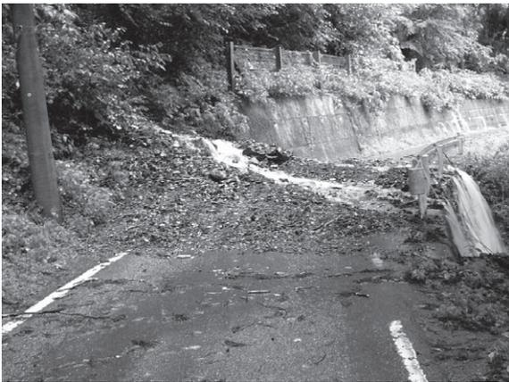
写真-2 道路に流出した土砂
