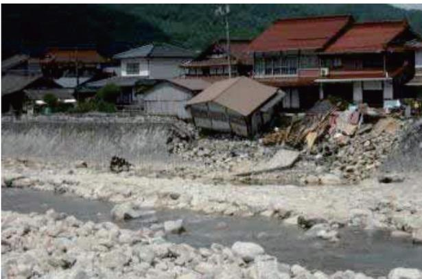
写真－4 破堤状況（東広島市河内町）
