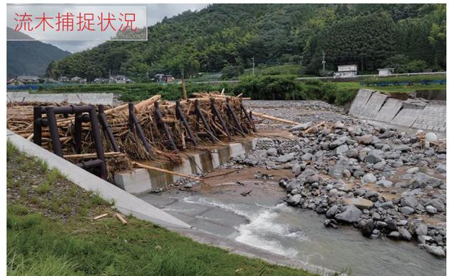
図-11 小野川 流木捕捉状況
