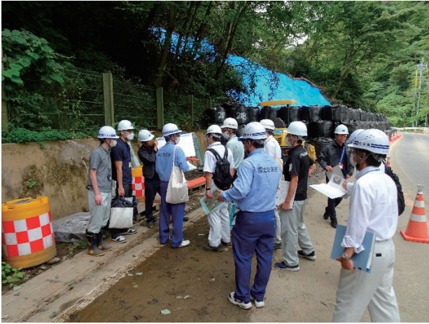
写真－6 緊急調査実施状況
