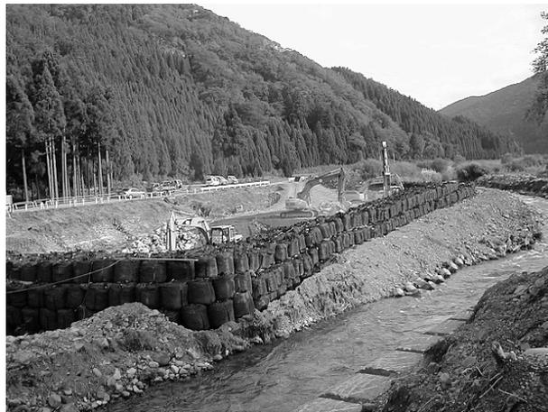
「耐候性大型土のう」の設置事例（福井県日野川）
