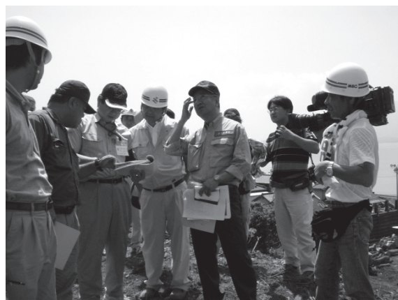
台風4号及び梅雨前線災害の緊急調査 たふみずし (鹿児島県垂水市)
