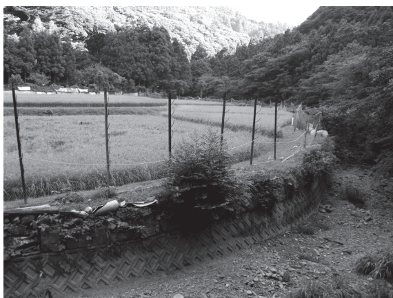
護岸の上に設置された周囲柵（長崎県対馬市）
