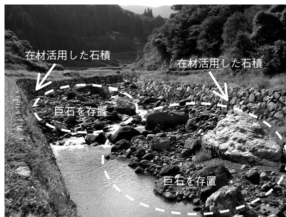
在材活用した石積護岸で復旧するとともに、異常堆積土砂の撤去において巨石を上手に残し、環境景観および親水機能を復旧した事例 (H17災 やまつきがわ 山附川河川等災害関連事業 にしうすきぐんたかちほちよう 宮崎県西臼杵郡高千穂町)
