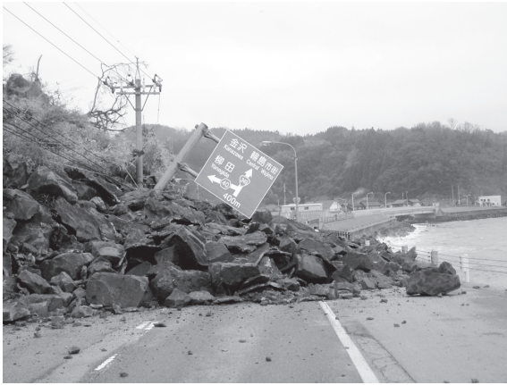
能登半島地震 国道249号 (石川県輪島市) わじまし
