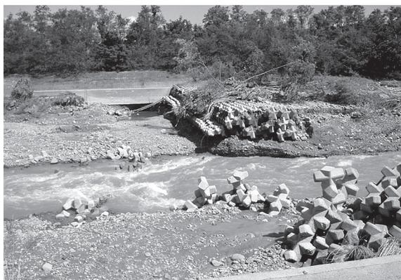
前述のとおり、村山地方の多くの河川では、河床洗掘を原因とする施設災害が極めて顕著であり、河川災害93箇所のうち32箇所(約35%)で河床洗掘防止施設の原形復旧又は再度災害防止のための対策工法が査定決定された。
