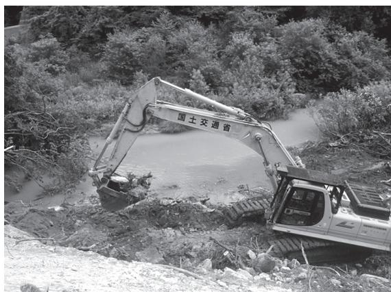
写真－9 産女川地区における無人化施工機械による除石工事
