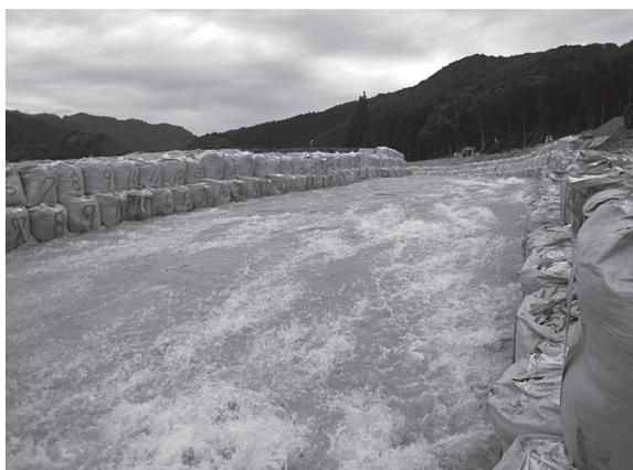
写真－7 宮城県小川原地区で施工された仮排水路
