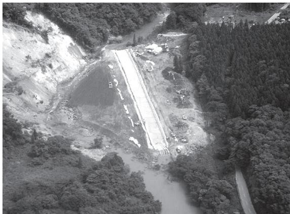
写真－6 宮城県浅布地区で施工された仮排水路
