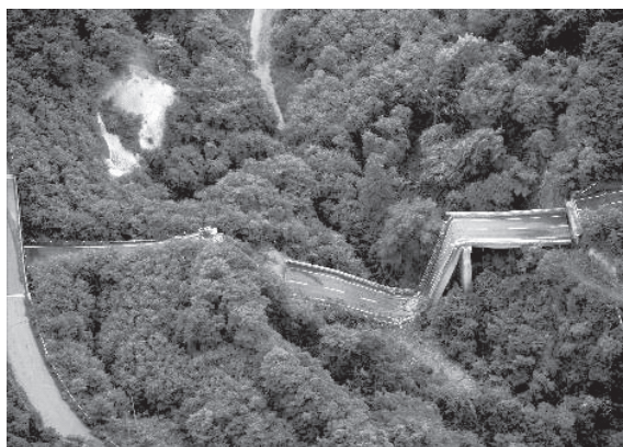
一般国道342号線 まつるべ 祭時大橋（岩手県一関市巖美町）
