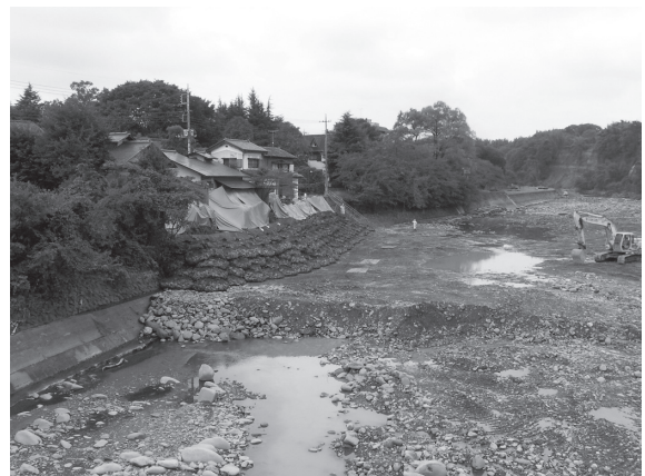
応急工事の実施事例（被災護岸コンクリート殻を利用した袋詰玉石工で欠壊防止）
