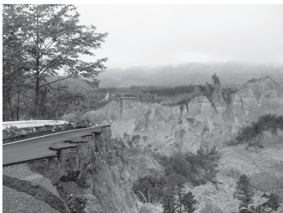
1級市道荒砥沢線（宮城県栗原市）
