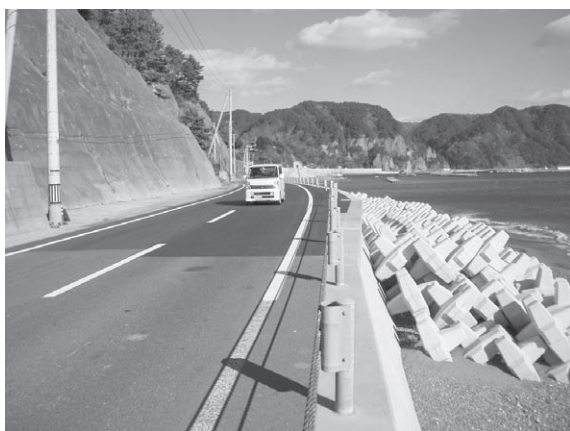
本復旧完了、2 車線開通
