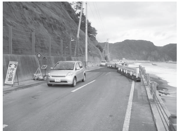
応急復旧完了、1車線暫定開通（10月25日）
