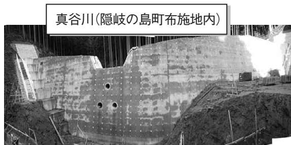
工期の短縮を図るため残存型枠を使用
