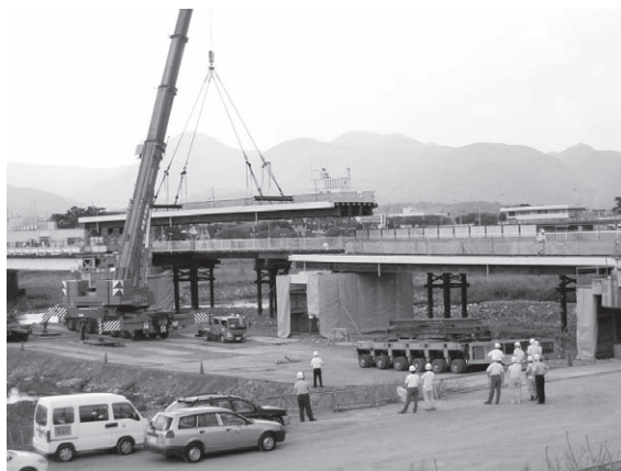
写真－10 橋桁の架設
