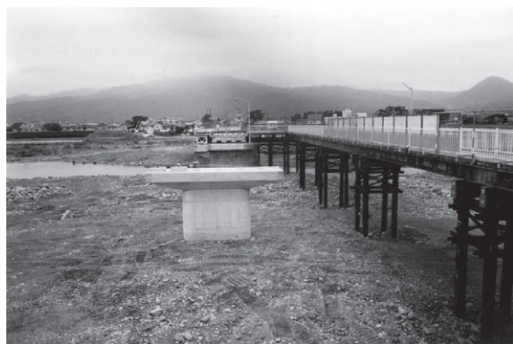
写真－9 橋脚が完成
