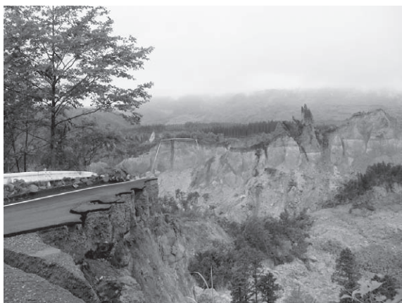
1級市道荒砥沢線（宮城県栗原市）
