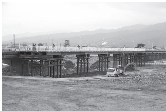
写真－8 仮橋が完成
