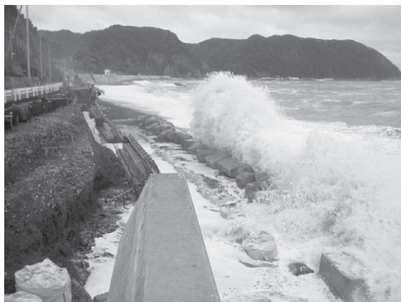
本復旧施工中の高波（平成 19 年 7 月）
