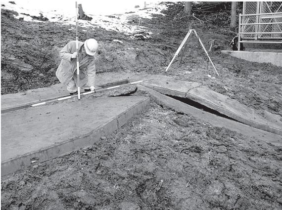
写真-2 水路工の被災状況(平成19年3月14日)
