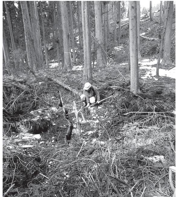
写真-3 林道から下った谷部に発生した亀裂(平成19年3月19日)
