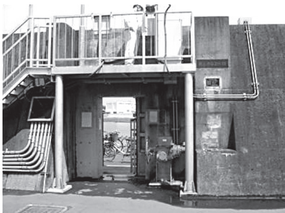
狩野川 陸閘閉鎖訓練
