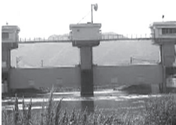
丸子川水門 閉鎖訓練
