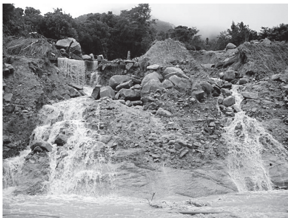
国道262号（防府市下右田）土石流の状況
