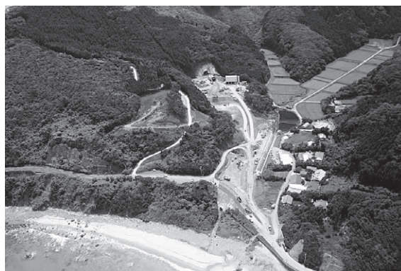
2 期施工の最盛期の航空写真
