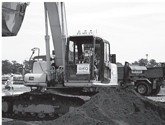
ロボQ搭載のバックホーを用いた道路啓開訓練
