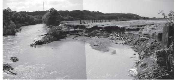
図-10 土羽護岸被災状況 (H15)
