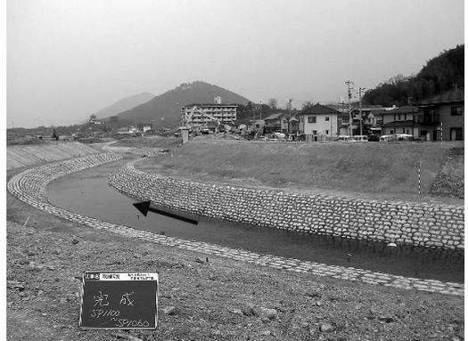
写真-4 盛土補強工法による築堤施工手順
