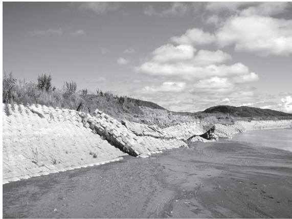
図－5 ブロック護岸被災状況
