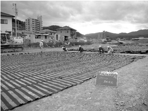
盛土補強工の完了後 直ちに築堤工に移る
