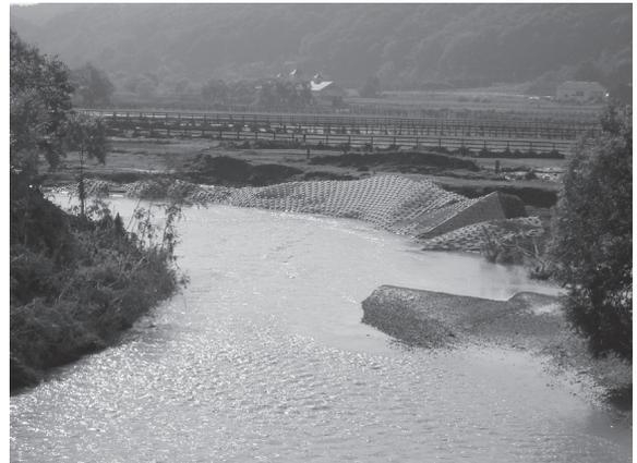
図-11 ブロック護岸被災状況 (H15)
