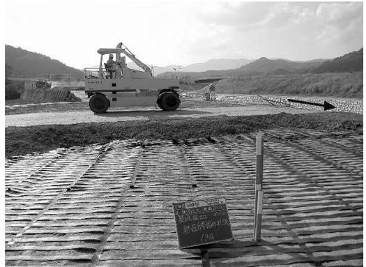
↓ 盛土補強により円弧すべりを起こすことなく築堤を完了
