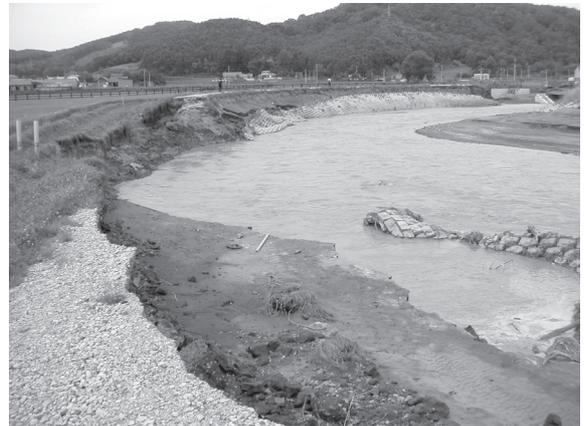
図－6 土羽護岸被災状況
