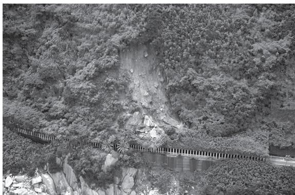
写真-7 ロックシェッド上に堆積した土砂・落石
