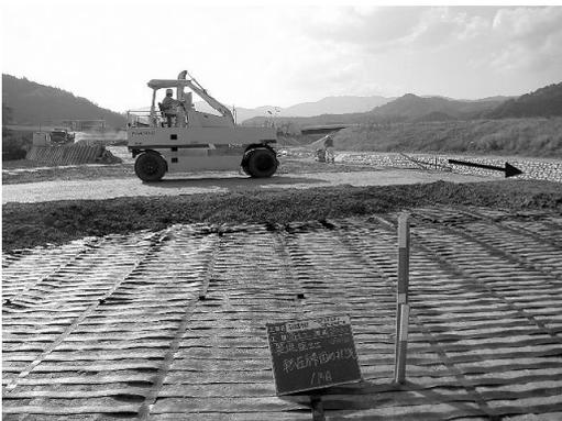
③敷設完了後、直ちに築堤材を搬入
