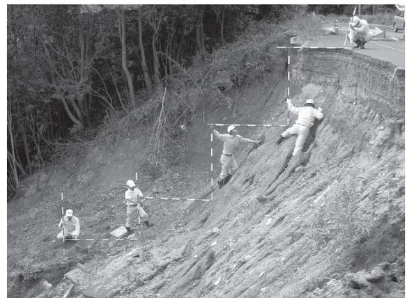
写真-4 被災箇所を測量している様子
