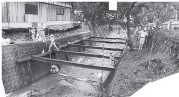
応急工事の実施事例（河積を確保しつつ欠壊防止を図るためH鋼による山留・切梁を実施）
