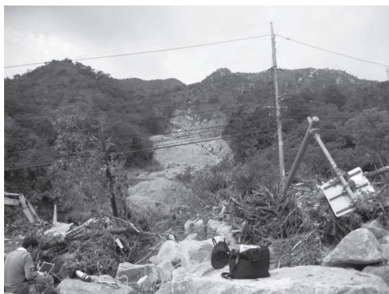
土石流による国道262号の被災状況（山口県防府市）
