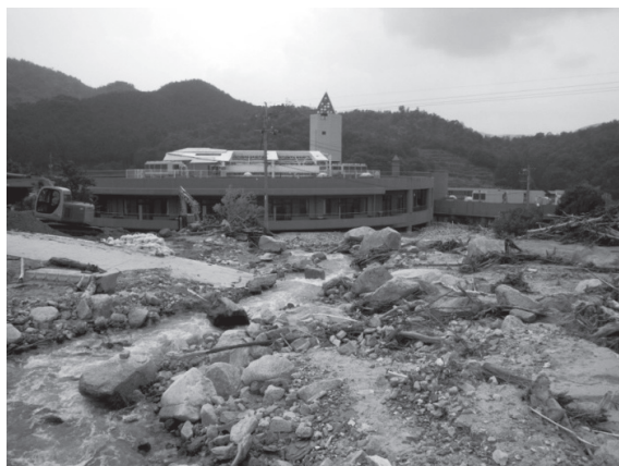
土石流による防府市真尾地区の被災状況（防府市真尾）
