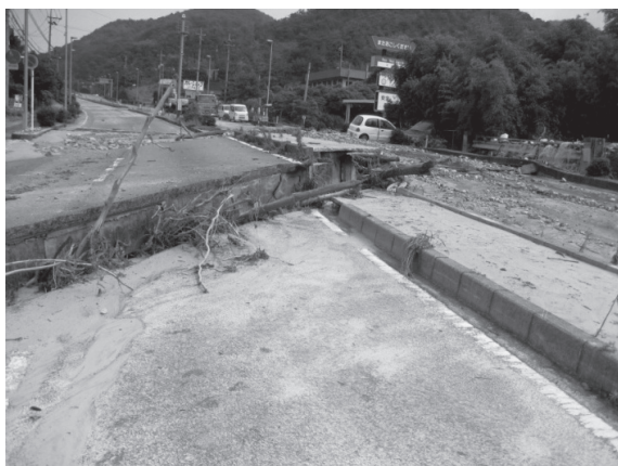
国道262号 上勝坂橋（山口県防府市）
