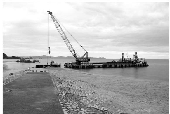
施工時における高波浪と2重締切鋼矢板
