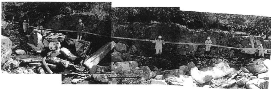
写真-2 被災状況 (側方浸食)
