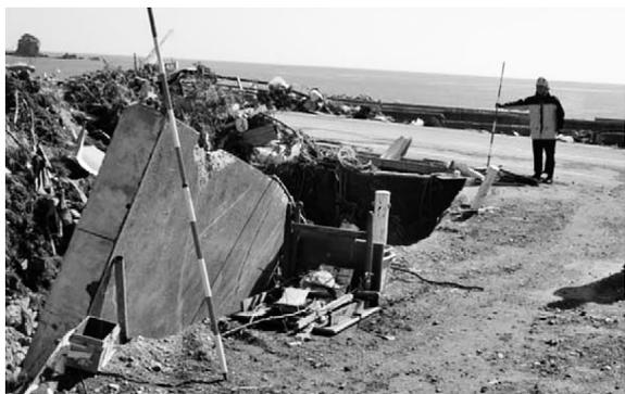
道路の被災状況調査（陥没箇所）
