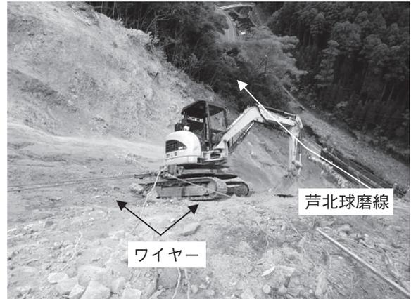
写真5-1 吊り下げ式小型バックホウ
