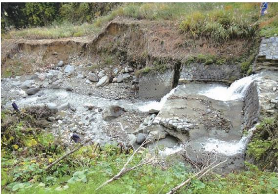
一級河川鎌倉沢川（洪水による砂防堰堤等の被災状況）
