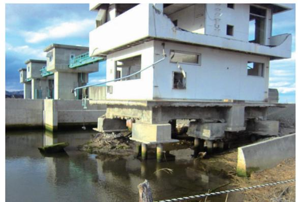
坂元水門（津波による水門の被災状況）
