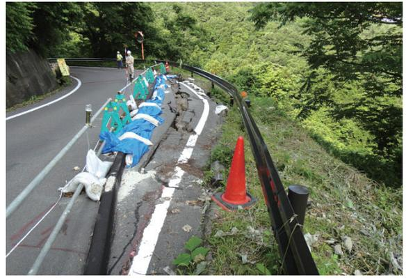
(主)白石国見線(地震動による谷側路面の被災状況)
