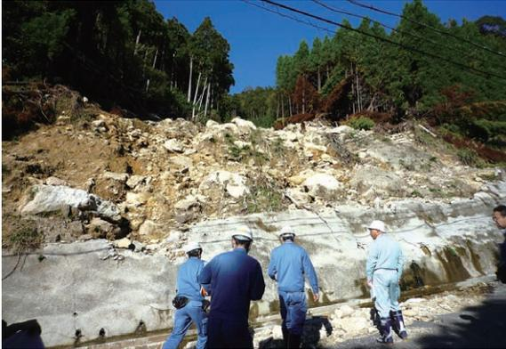
一般県道飛鳥日浦線（降雨による道路山側法面の崩落状況）
