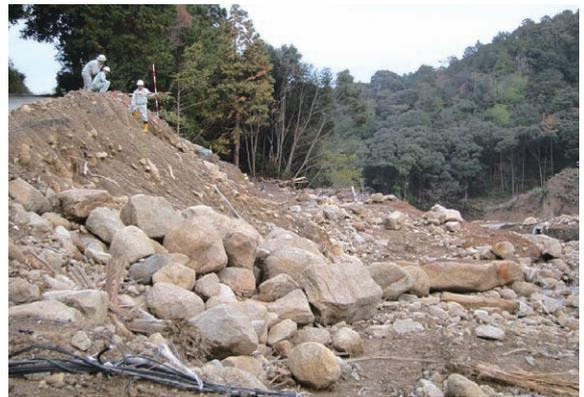
（主）那智勝浦古座川線（土砂流出による河川を横断する道路の損傷と埋塞の状況）（和歌山県那智勝浦郡）
