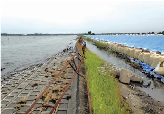
一級河川<sup>ひぬま</sup>湊沼川（地震動による堤防の沈下状況）
