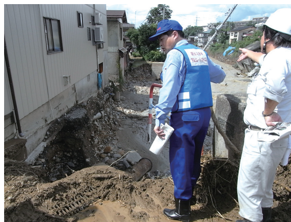
写真3-2 TEC-FORCEによる現地調査
