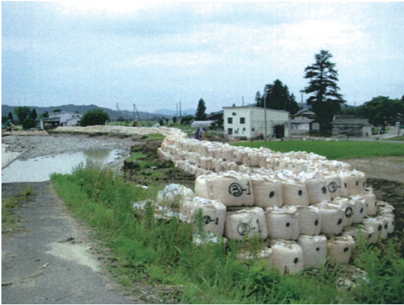
写真4-1 五十嵐川応急復旧状況（三条市江口地内）
