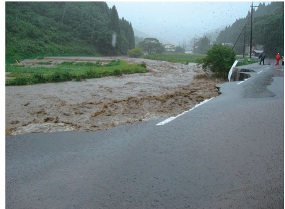
被災状況写真③
