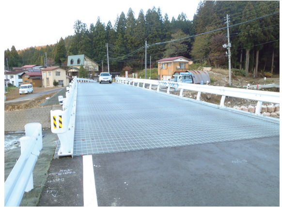
写真4-2 六箇橋応急復旧状況（十日町市麻畑地内）
