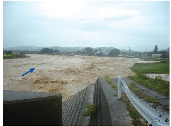
写真5-2 五十嵐川破堤状況（三条市江口地内）
