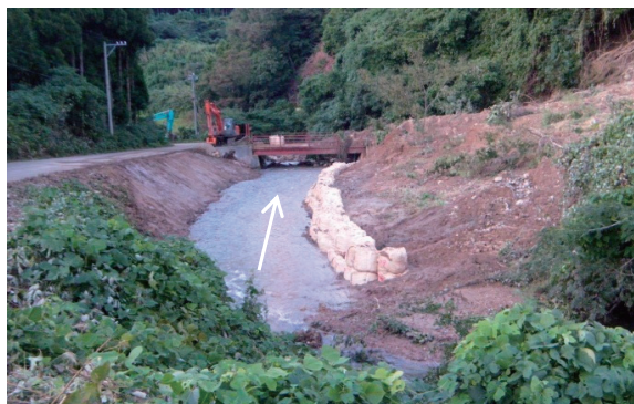
河道閉塞土砂 撤去状況
