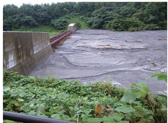
写真-7 堤体直下流側洗掘状況
