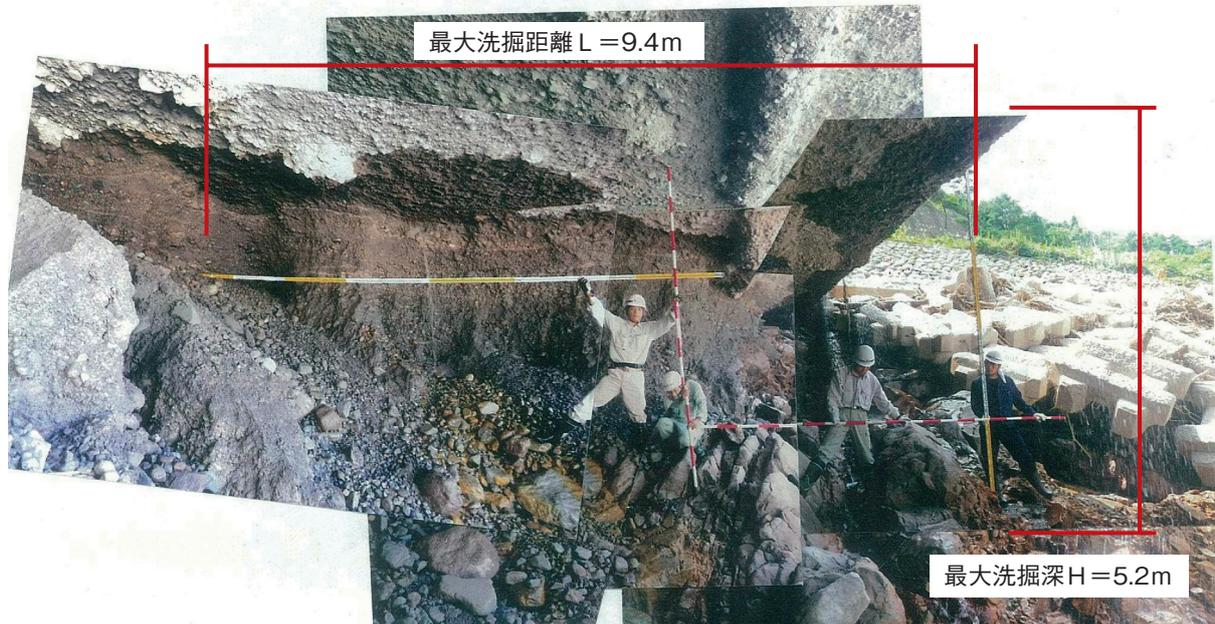
写真-9 堤体下部洗掘状況
