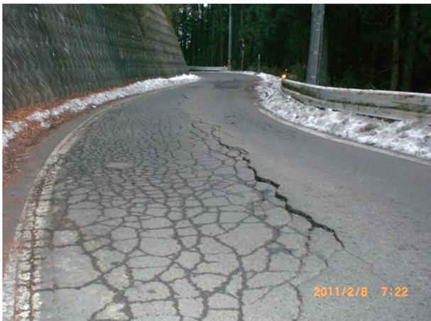
舗装面の亀甲状クラック及び盛上がり、沈下（岐阜県）
