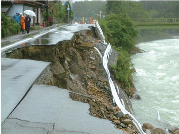
道路法面崩壊 一般県道湯屋温泉線
