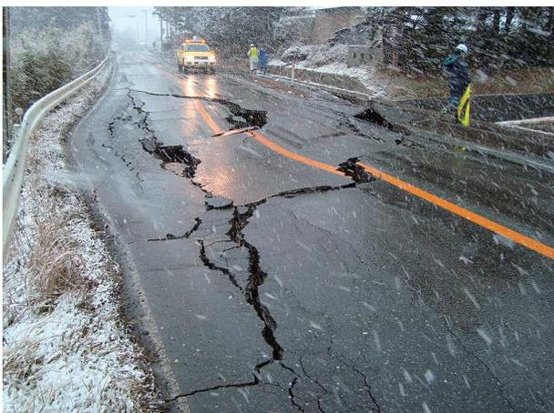
地震による路面の亀裂
