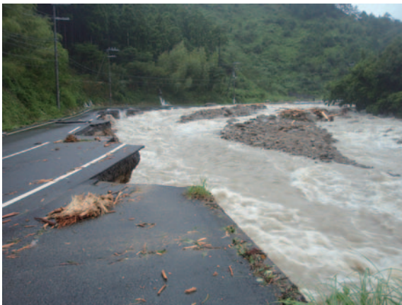
写真－1 二級河川井戸川の決壊状況
