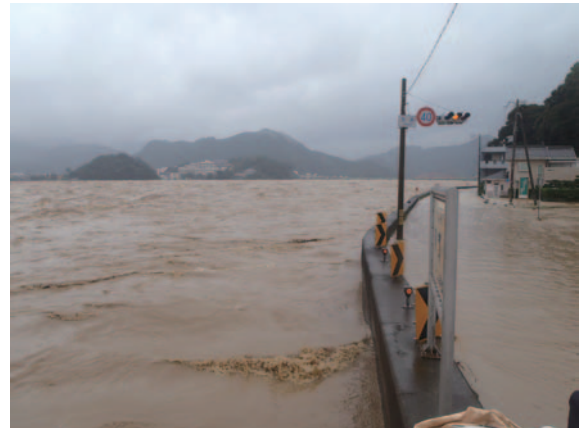
写真－2 一級河川熊野川の氾濫状況
