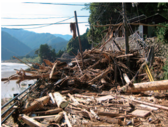
写真－4 県道小船紀宝線の被災状況
