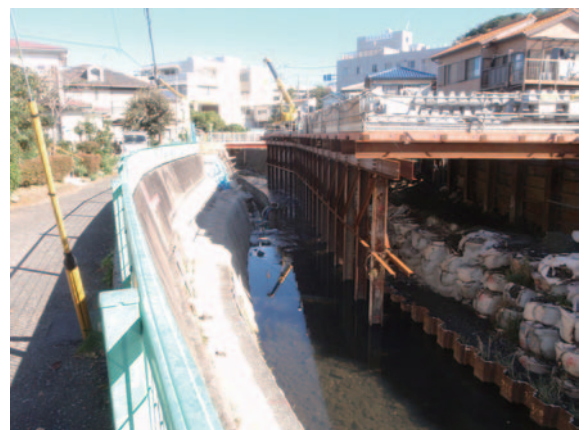
写真－2 大岡川復旧工事状況（平成24年11月）
