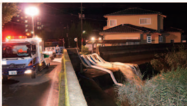
排水ポンプ車による排水作業(福岡県柳川市)
