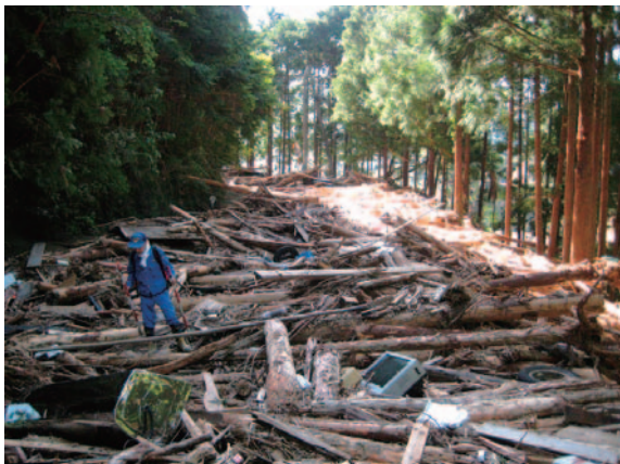
写真－3 県道小船紀宝線の被災状況
