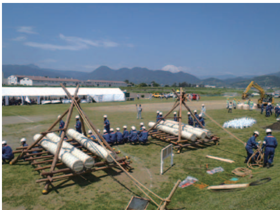
写真－9 水防工法実演（四つ枠工）
