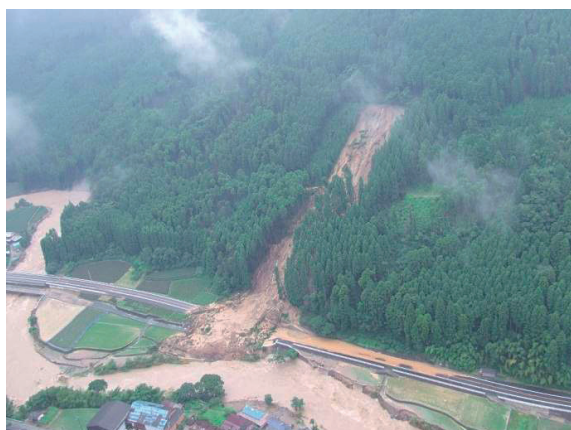
県道八女香春線における法面崩壊（福岡県）
