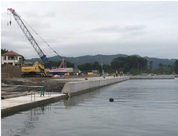
写真-6 織笠漁港災害復旧工事状況
