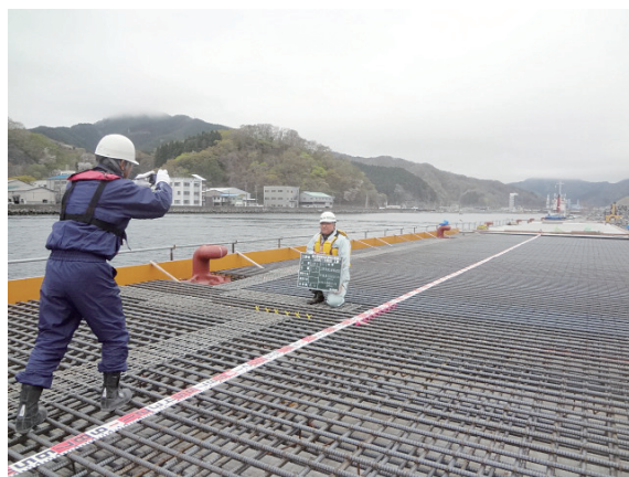
写真-1 釜石港嵩上げ工立会状況
