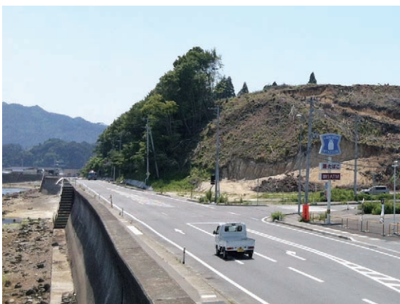
写真-7 既設防潮堤と国道と高台移転
