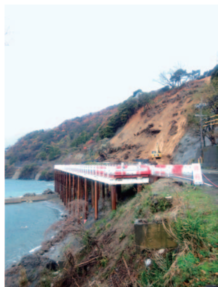
福井県 常神三方線 飯橋
