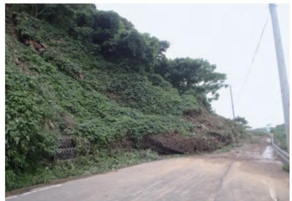
H25.9 (主)輪島浦上線法面崩壊（輪島市）
