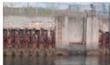
鋼矢板の腐食・コンクリートの劣化
