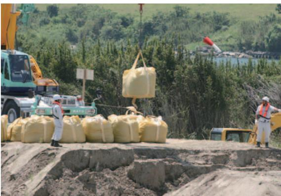
大型土のう工による堤防復旧訓練
