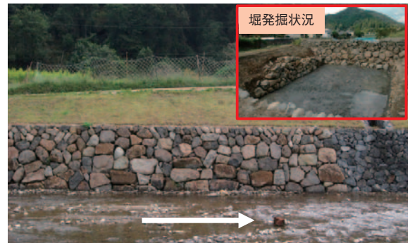
写真-3 護岸整備状況（石垣石材活用）
