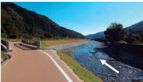
写真-2 遊歩道等整備状況
