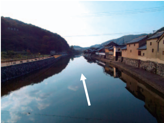
写真-1 川端風景と改修状況
