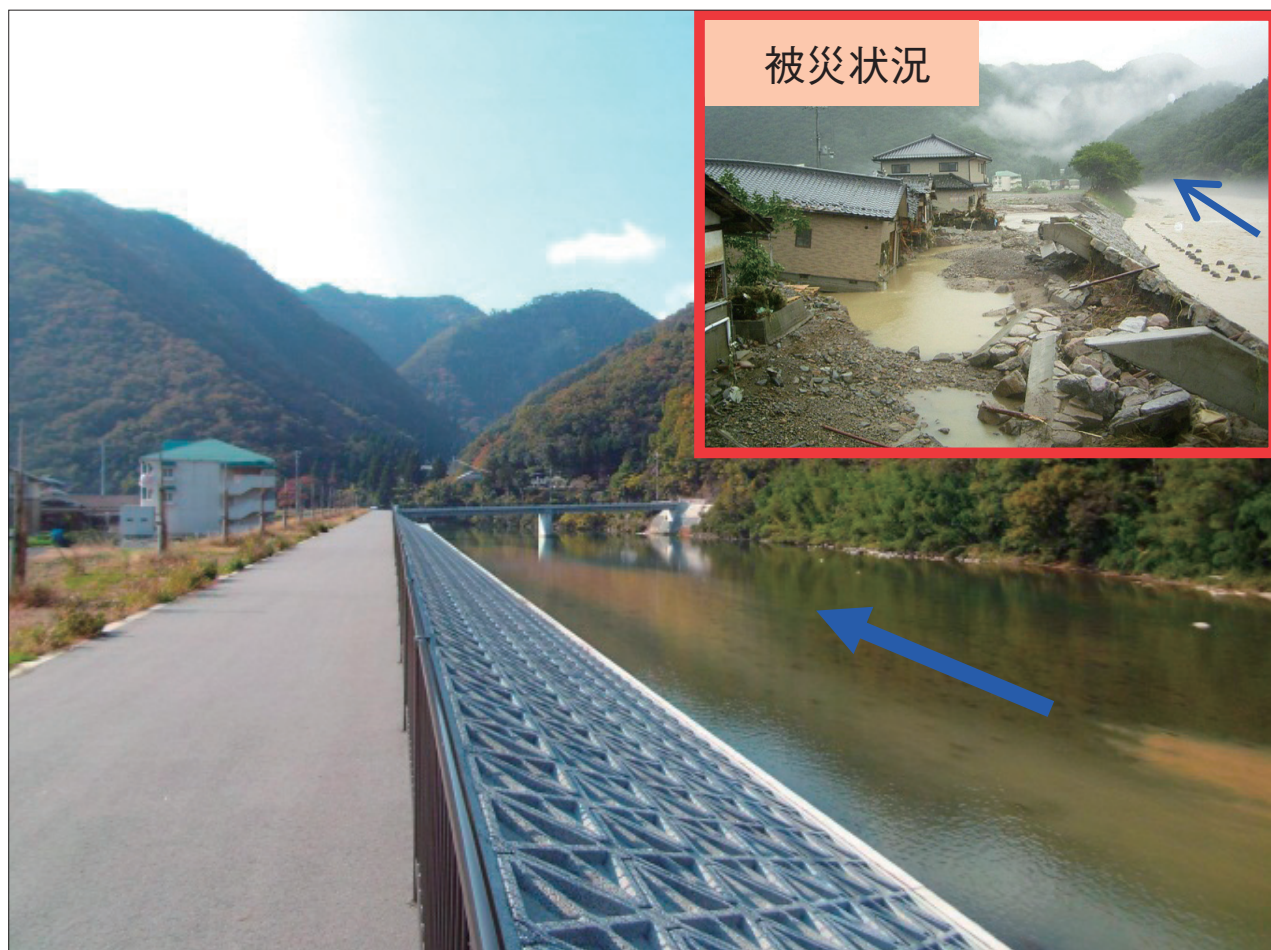
兵庫県佐用町久崎地区整備状況
