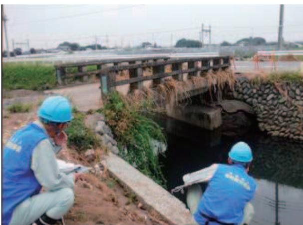
橋台が沈下し上部工が浮いている状況（金比羅橋）
