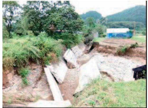
護岸ブロック倒壊、河岸欠壊状況（野中川）
