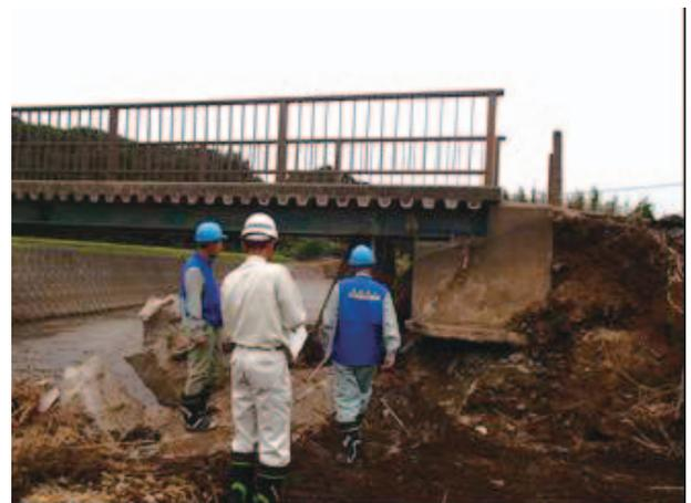
護岸被災と橋台下面の洗掘被害状況（市道7053号）
