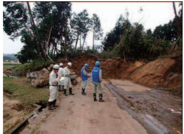
斜面すべり崩壊による道路埋没状況（市道0009号）
