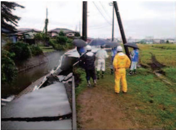
護岸ブロック倒壊、兼用道路被災状況（西武子川）
